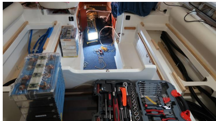
Vorbereitung zum Batterieeinbau
